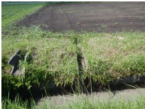
○ 明渠を排水路へ接続
