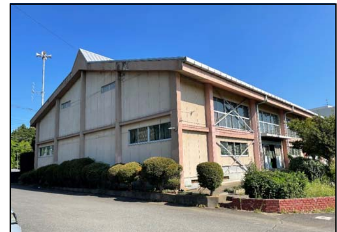
納場小学校体育館
