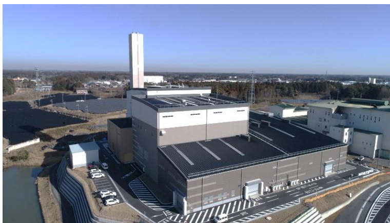
写真 クリーンセンターみらい
