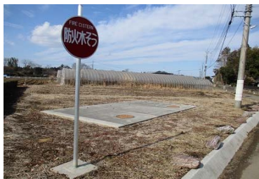
地域を延焼から守る防火水槽
