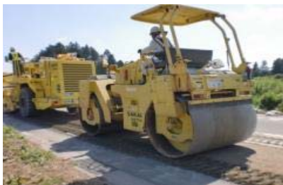
道路補修工事
