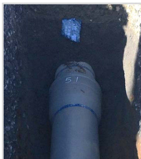
配水管工事状況 管種：DIP-GX (耐震管) 口径：φ 300
