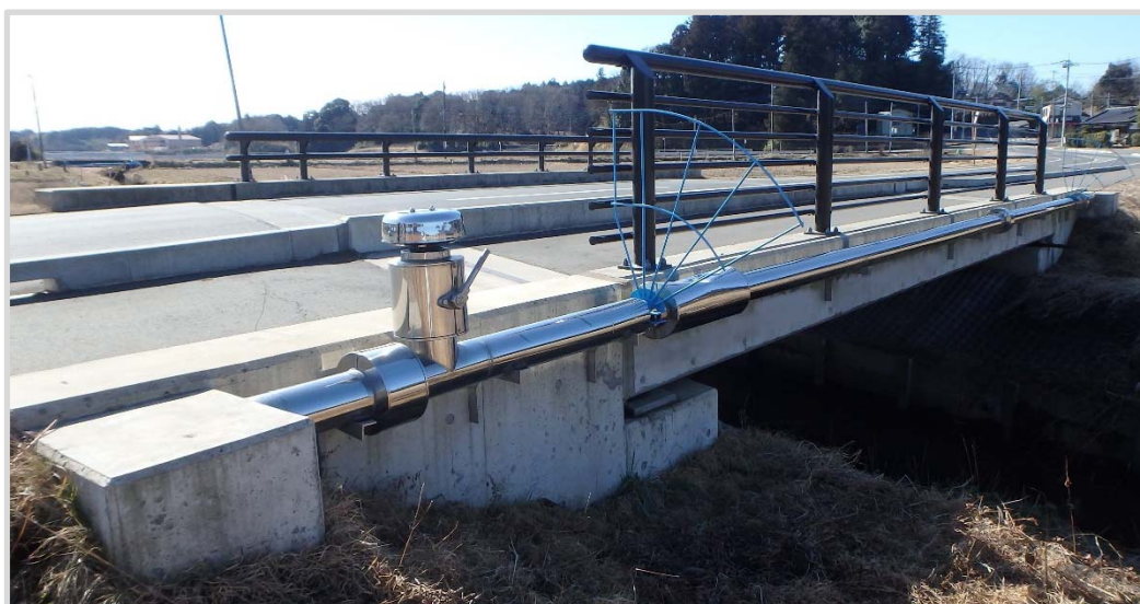
小川地区 水管橋
