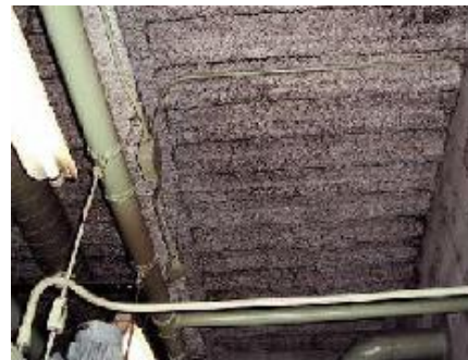
石綿含有スレート波板(屋根・外壁)
