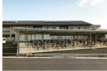
⑦ 【屋根付き駐輪場】 ・義務教育学校として新設した場合にも自転車の利用想定数を満たす大きさです。 ・できるだけ既存を活用したいと考えます。
