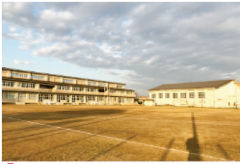
①【南西側から校舎と体育館をみる】 ・広いグラウンドで空も広く、外部環境に恵まれています。 ・のびのびとした広さを大切にしたいです。
