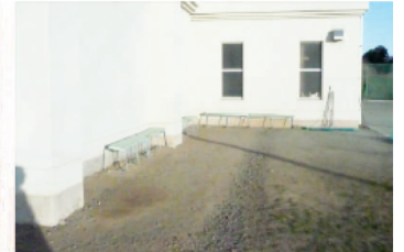
⑯ 【体育館と機械室のくぼみ】
