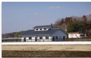
農業集落排水施設
