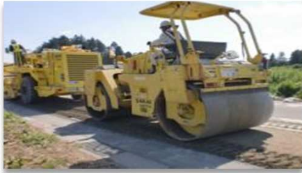
道路補修工事
