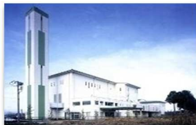
霞台厚生施設組合環境センター
