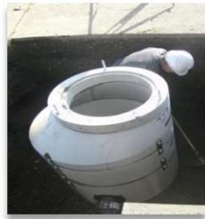
マンホール設置工事の様子
