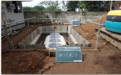
浄化槽設置工事の様子
