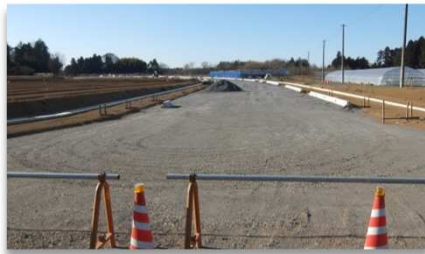
整備中の広域幹線道路
