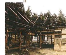
建物の当初の諸様式を発見するため精密な調査をすすめ、可能な限りの部材を復元するため慎重な解体工事が行われた。(平成7年度)
