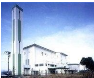
霞台厚生施設組合 環境センター
